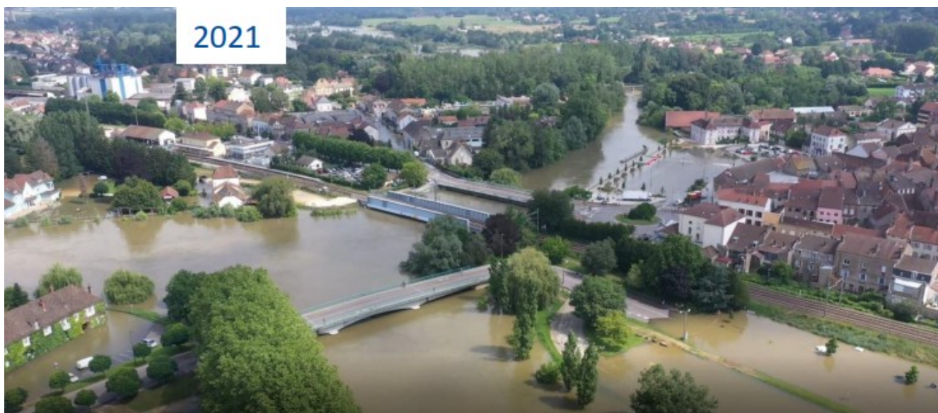
Crue de la Seille à Louhans en 2021 (image DDT)
